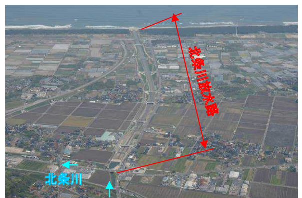
北条川放水路の整備状況(平成21年4月)
