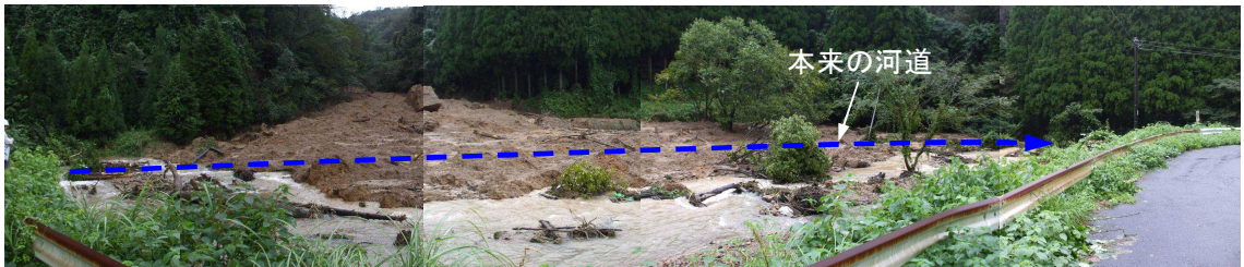
平成23年9月台風15号による土砂災害（鳥取市洞谷 洞谷川支川）
