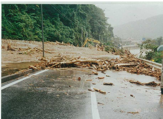
平成10年10月台風10号の被災状況(三朝町下西谷)
