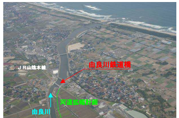
由良川鉄道橋の整備状況(平成21年4月)
