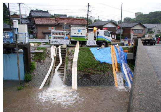
平成18年7月 梅雨前線出水 排水ポンプ車による内水排水状況（法勝寺川・米子市青木）
