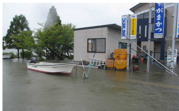
平成23年台風12号による浸水被害状況 (湯梨浜町松崎)
